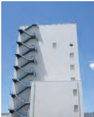
作業員の為の構内にある大型休憩所
